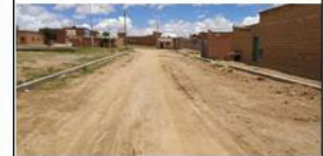
CORDONES DE ACERA
