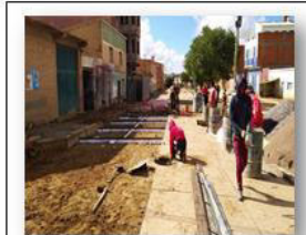
ENCOFRADO DEL PAVIMENTO
