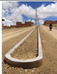
CORDONES DE ACERA CENTRAL
