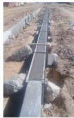
CORDON DE ACERA CENTRAL
