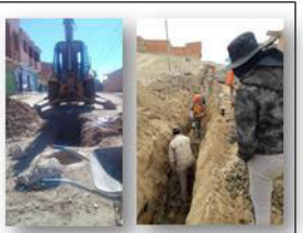
EXCAVACIÓN EN SUELO SEMIDURO ROCA
