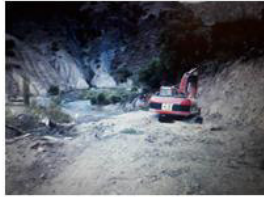
APERTURA DE CAMINO
