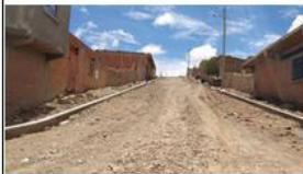
CORDON DE ACERA
