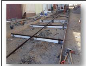
ENCOFRADO DEL PAVIMENTO
