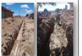
TUBERÍA Y COMPACTADO
