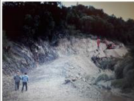
APERTURA DE CAMINO
