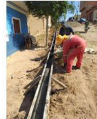
VACIADO DE CORDON DE ACERA
