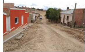
CORDONES DE ACERA CONCLUIDO
