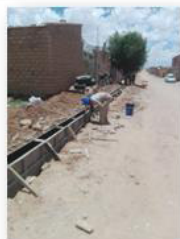
ENCOFRADO DE CORDON
