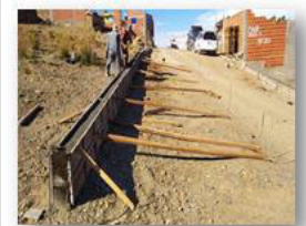
ENCOFRADO DE CORDON
