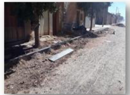
ENCOFRADO DE CORDÓN
