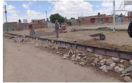
VACIADO DE CORDON DE ACERA
