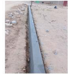
CORDON DE ACERA
