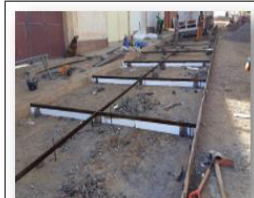
ENCOFRADO DEL PAVIMENTO
