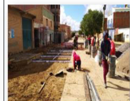
ENCOFRADO DEL PAVIMENTO
