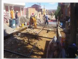
ENCOFRADO DEL PAVIMENTO
