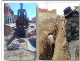
EXCAVACION EN SUELO SEMIDURO ROCA
