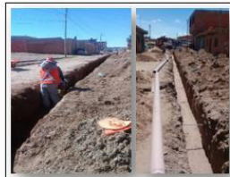
TUBERIA Y COMPACTADO
