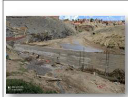
MURO DE CONTENSION DE M.C.C.
