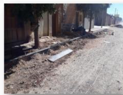
ENCOFRADO DE CORDÓN
