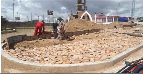
Construcción de jardineras en la OTB 19
