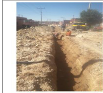
EXCAVACION PARA TUBERIA
