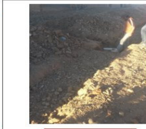
COMPACTADO DE SUELO
