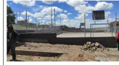
ACABADO MALLA OLIMPICA
