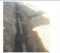
TENDIDO DE TUBERIAS
