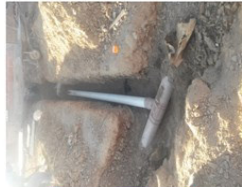
COMPACTADO DE SUELO
