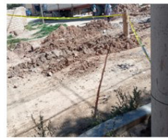
EXCAVACION PARA TUBERIA
