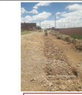
COMPACTADO DE SUELO
