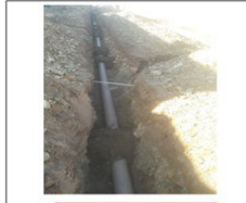
TENDIDO DE TUB. PVC SDR 41 d=6"
