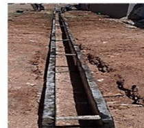
COLOCADO DE FORMALETA
