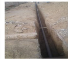
TENDIDO DE TUB. PVC SDR 41 d=6"
