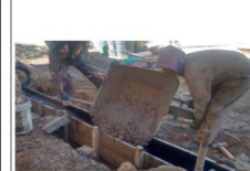
VACIADO DEL CORDON DE H"O"
