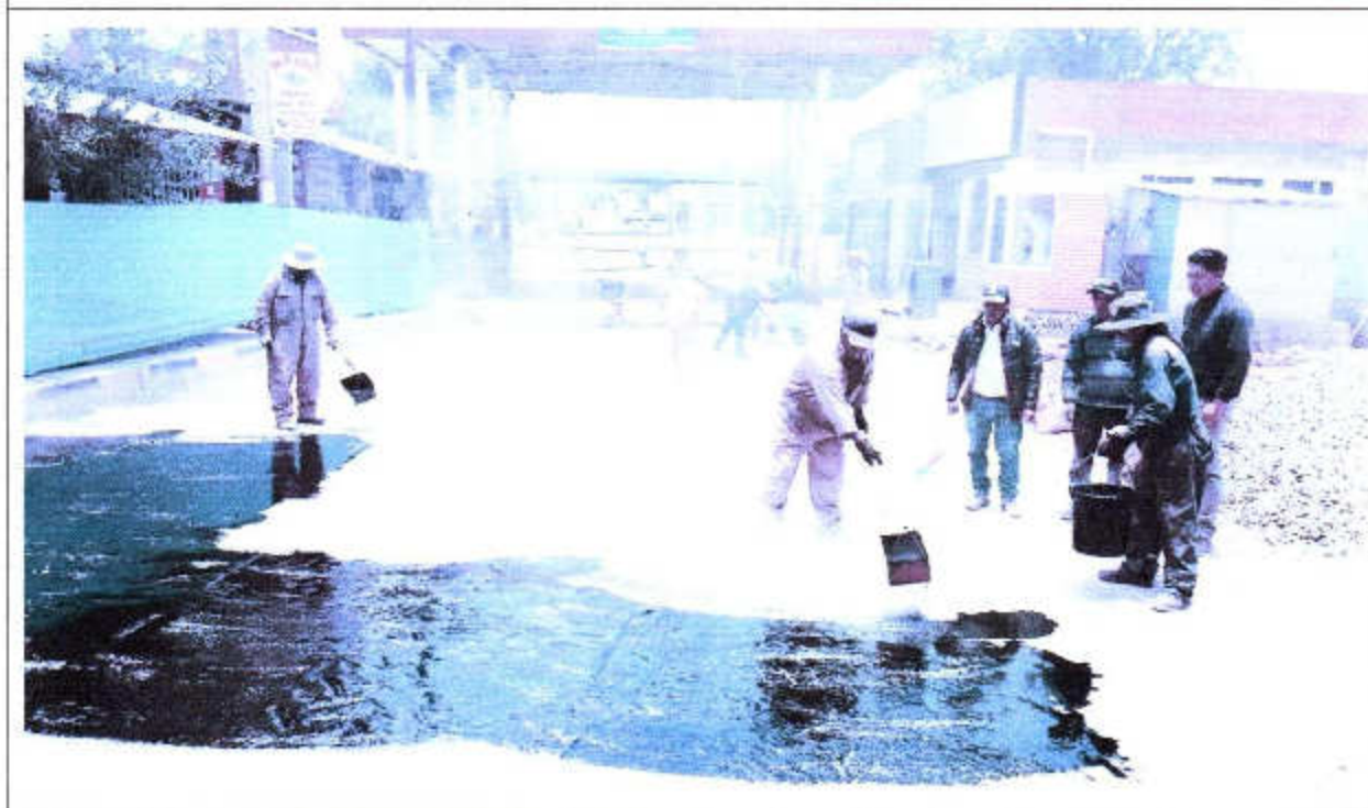
Imprimación nuevo pavimento rígido calle Cornelio Saavedra y puente internacional
