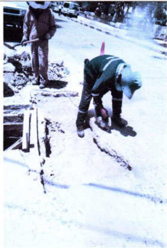
Mantenimiento de vías de concreto hidráulico
