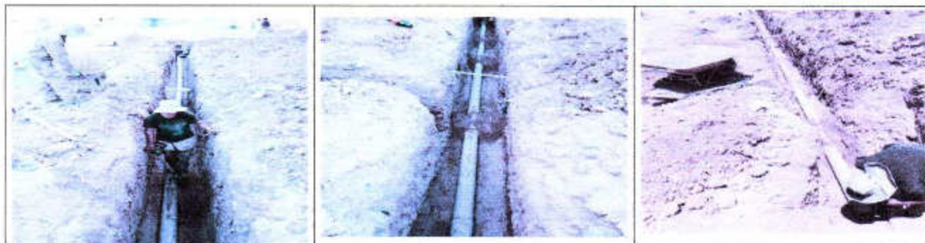
ÍTEM RELLENO Y COMPACTADO DE ZANJA
