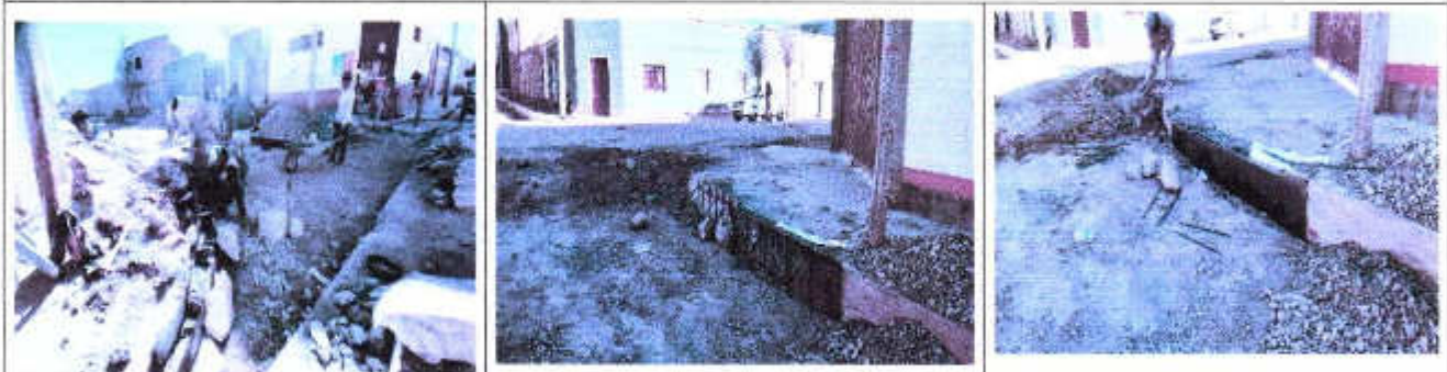
ÍTEM PAVIMENTO RIGIDO + PASAJUNTAS (P/FCK=250 KG/CM2) H=20CM. DOSIF. 1:2:2
