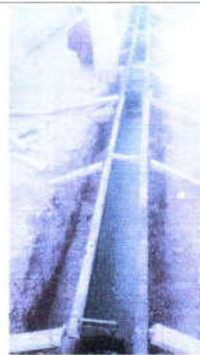
ENCOFRADO DE CORDONES
