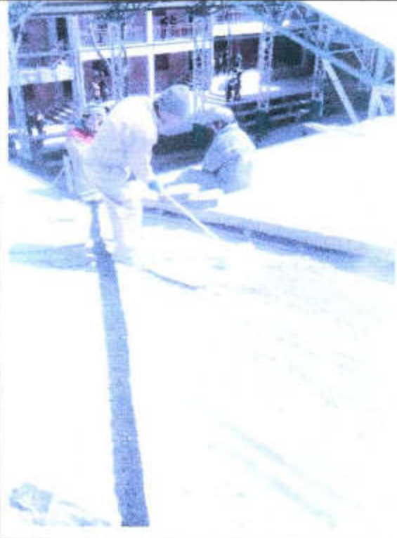
Construcción y colocado de rejillas para bocatormentas
