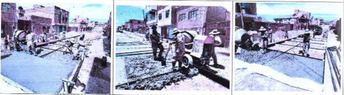
ÍTEM PAVIMENTO RIGIDO + PASAJUNTAS (P/ FCK=250 KG/CM²) H=20CM DOSIF. 1:2:2
