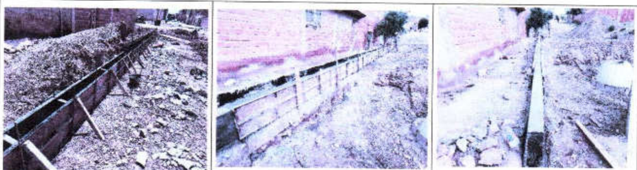
ÍTEM PAVIMENTO RIGIDO + PASAJUNTAS (P/ FCK=250 KG/CM²) H=20CM DOSIF. 1:2:2
