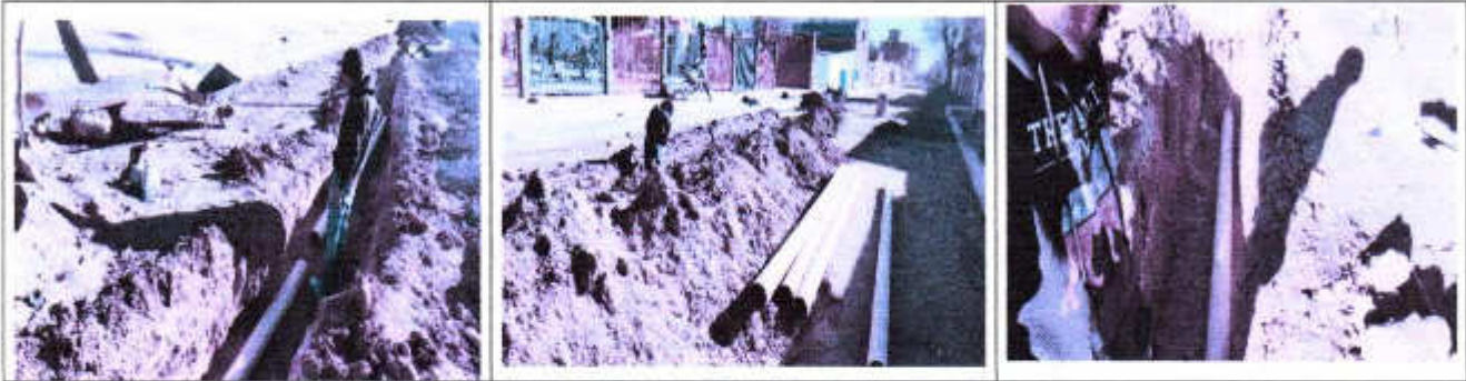
ÍTEM RELLENO Y COMPACTADO DE ZANJA
