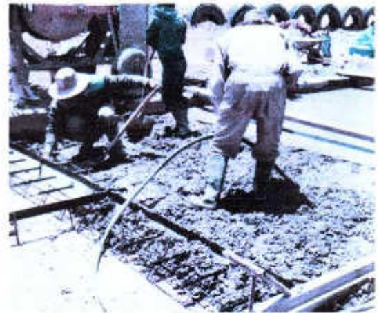
VACIADO DE PAVIMENTO
