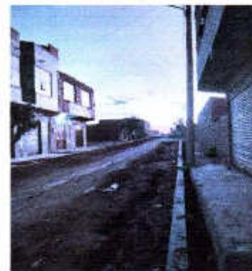
VISTA DE LOS CORDONES DE ACERA
