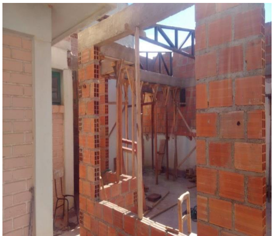
CONST DE MUROS Y VIGAS
