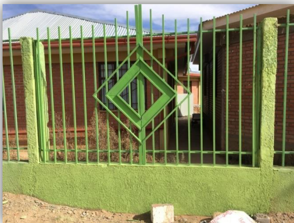
COLOCADO DE REJAS
