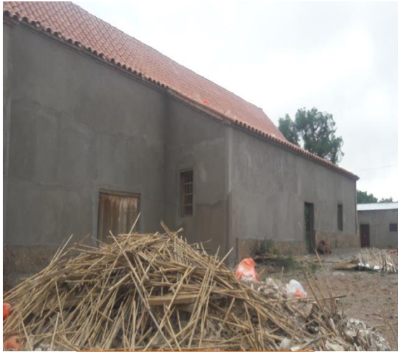
REPARACION DE CUBIERTAS
