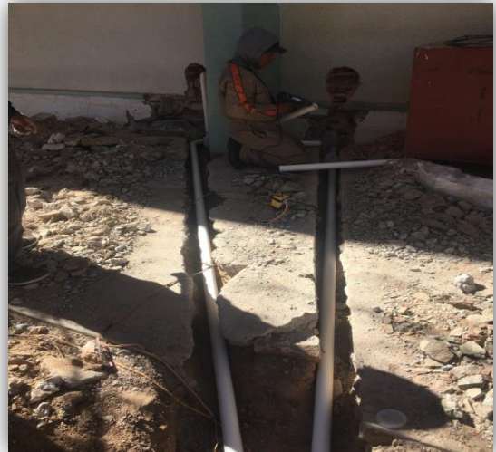
TENDIDO DE TUBERIA
