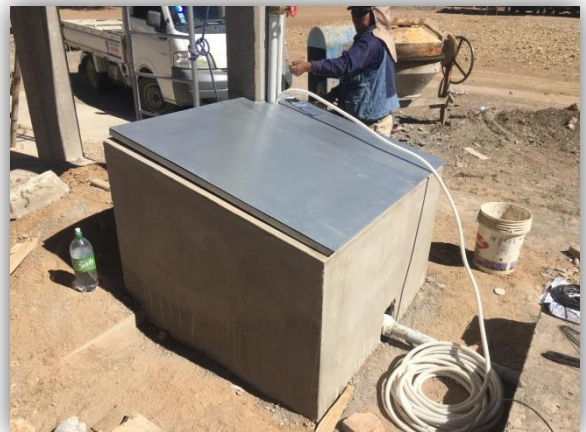
CASETA DE BOMBAS
