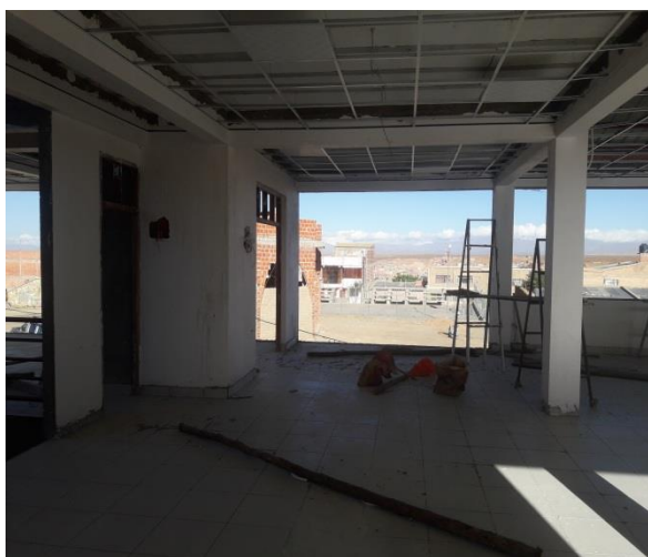
COLOCACION DE PERFILES PARA PLACAS
