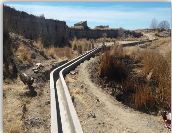
CANALES DE H°C
