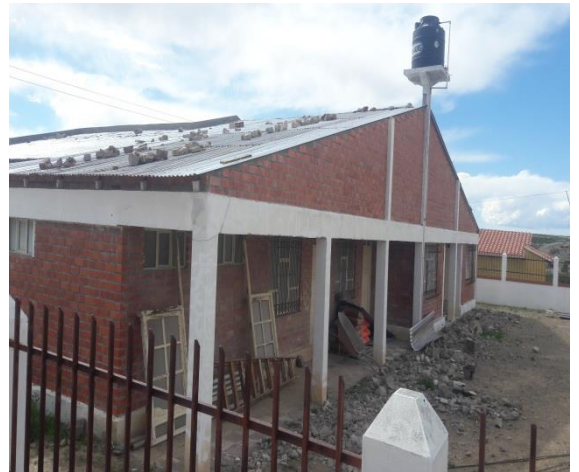
REPARACION CUBIERTA DE CALAMINA
