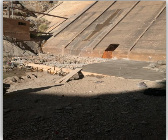
PROTECCION CON ENROCADO
