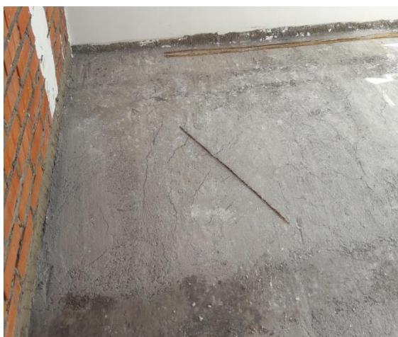
VACIADO DE PISO
