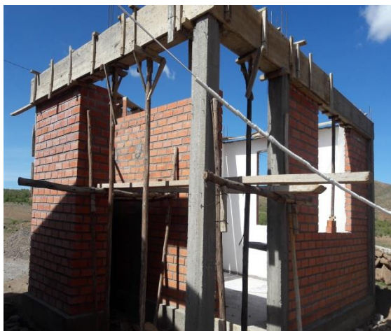
CONSTRUCCION DE MUROS Y VIGAS
