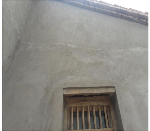
REPARACIÓN DE VANOS
