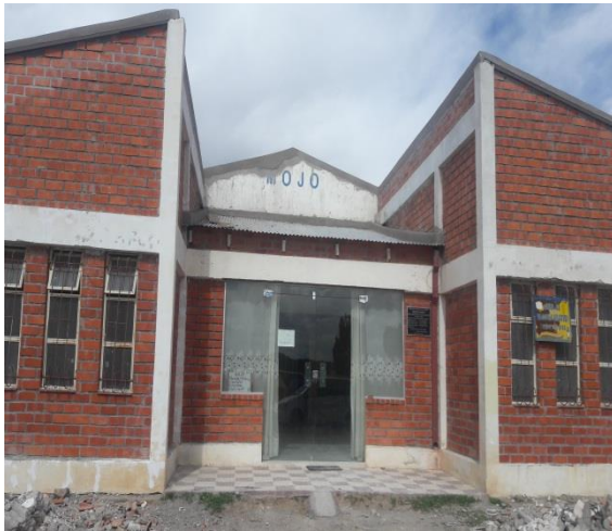
REMOCION DE CUBIERTA
