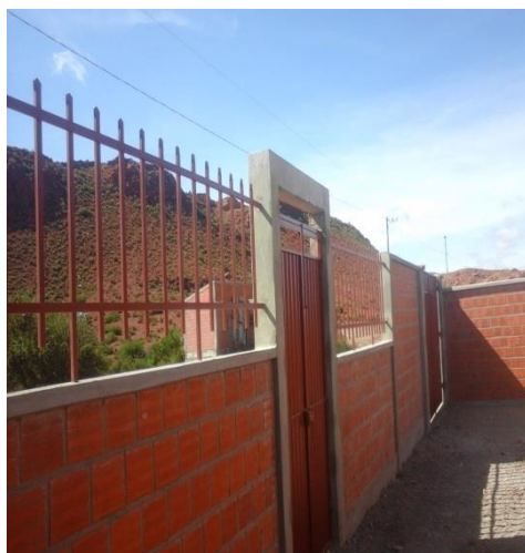
REJAS DEL MURO
