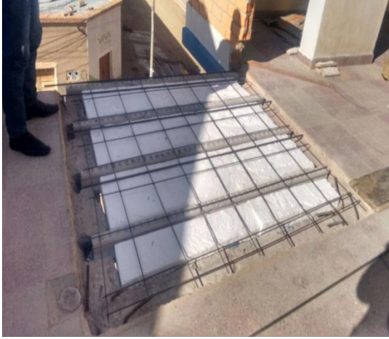
ARMADO DE LOSA ALIVIANADA
