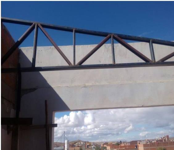
COLOCACION DE CERCHAS METÁLICAS
